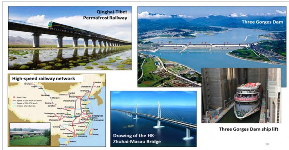
42. 就拿建筑在永冻层上的青藏铁路为例。其工程上的种种挑战就包括——永冻层会因为气温上的微小变化而融化，而火车的高温也会使之融化；永冻层融化后，满地泥泞将影响铁路系统的整体运作。在较脆弱的铁路段，中国的工程师在深入地底的桩基上建起高架轨道。中国在短时间内成功地在永冻土上建筑铁路网络，确实令人瞩目。
